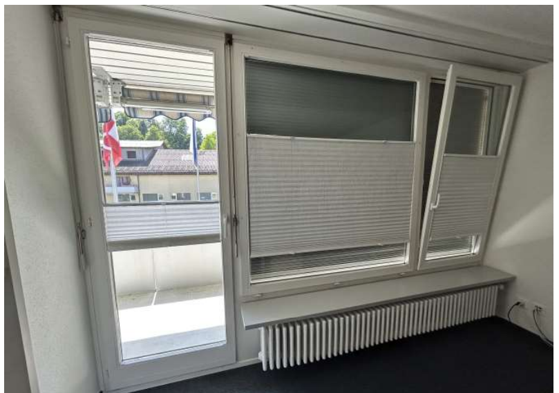
Fensterfront Büro Betriebsamt Süd-West OG
