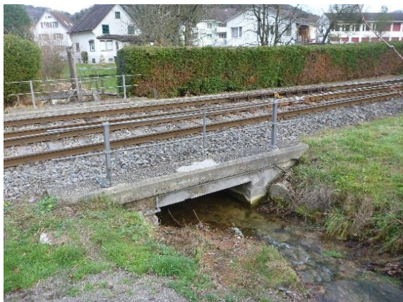
Brücke bei km 0.20 (SBB-Brücke)
