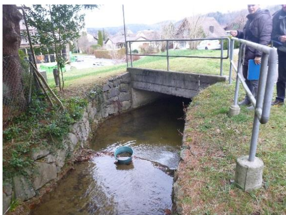
Eindolung bei km 0.36 (Huebweisstrasse)
