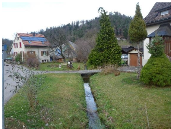
Brücke bei km 0.09
