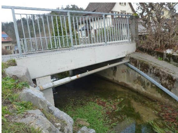
Brücke bei km 0.11 (Tablatstrasse)
