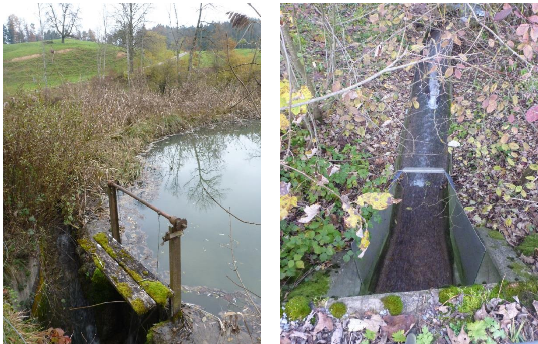
Abbildung 5: Bodenweiher, links: Blick auf den Hauptweiher mit Durchlass und Holzschieber, rechts: Schussrinne unterhalb Damm
