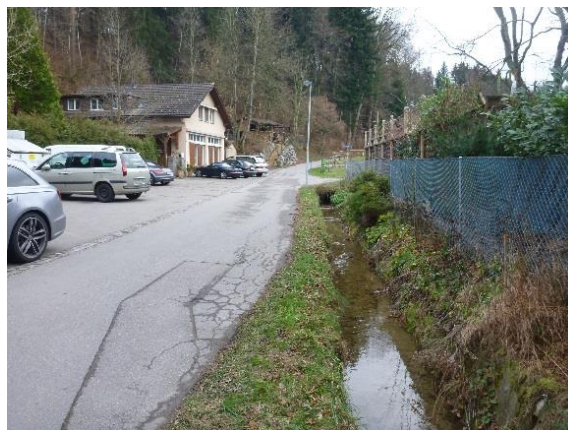
Offenes Gerinne bei km 0.38 (Blick gegen Fließrichtung)
