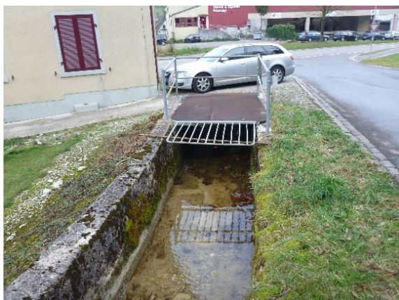
Durchlass bei km 0.29 (Tösstalstrasse)
