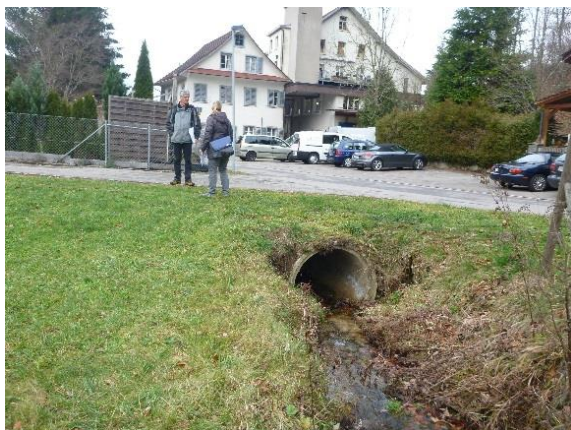
Eindolung bei km 0.43
