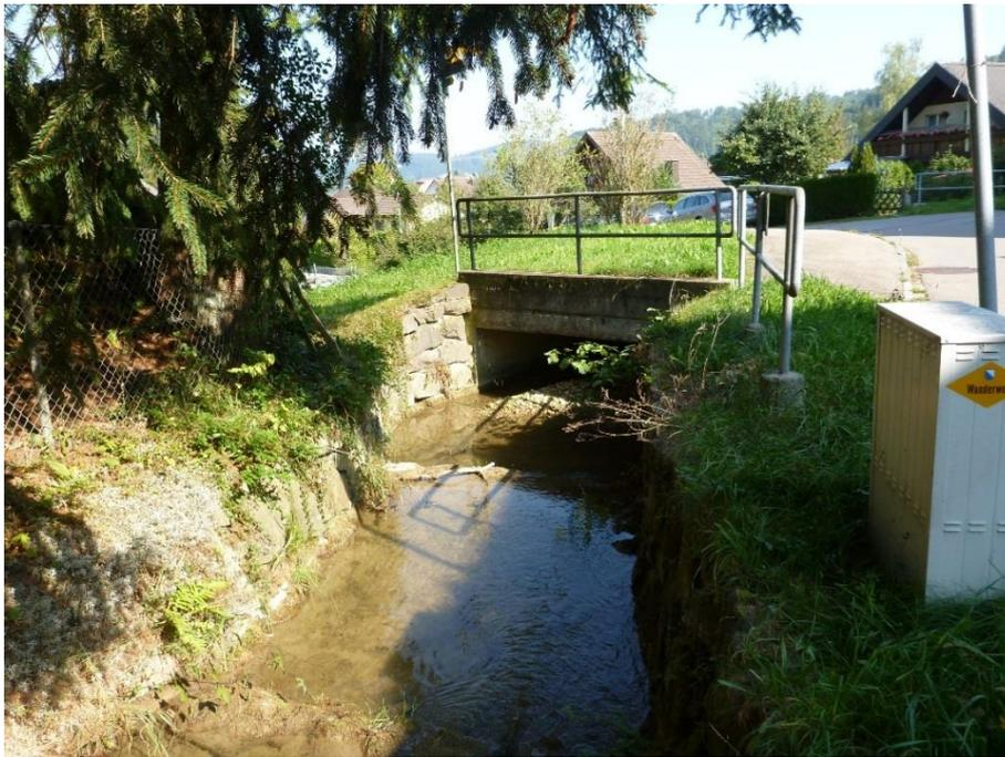
Abbildung 11: Geschiebeablagerungen im Bereich der Brücke Huebwiesstrasse
