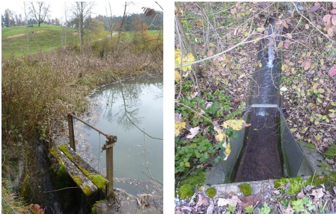
Abbildung 7: Bodenweiher, links: Blick auf den Hauptweiher mit Durchlass und Holzschieber, rechts: Schussrinne unterhalb Damm
