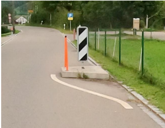
Abbildung 3: bestehende Betonelemente in Au
