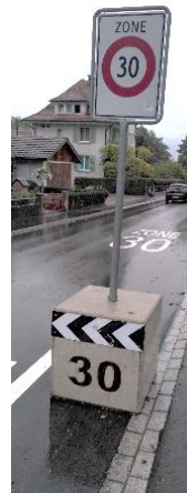
Abbildung 4: Eingangstor mit Betonwürfel
