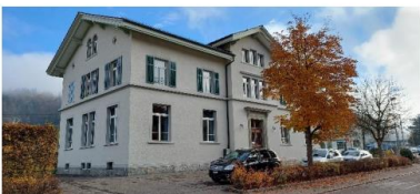
Altes Primarschulhaus Stationsstrasse 11
