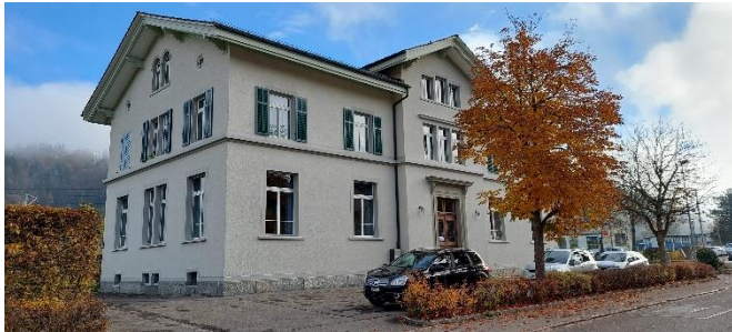
Altes Primarschulhaus Stationstrasse 11
